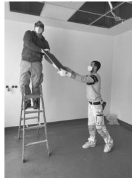
Die Umbaumaßnahmen haben begonnen: hier die Räume der zukünftigen Palliativstation.
